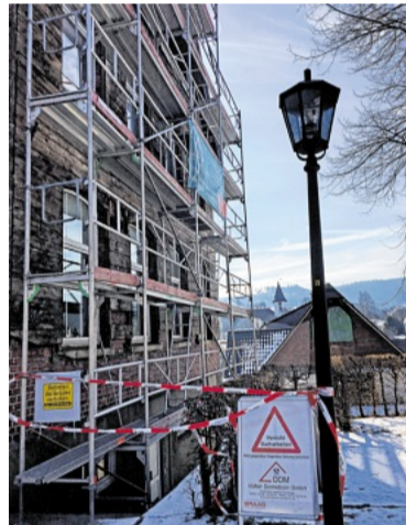
Die Außenfassade am Heimatmuseum des oberen Lahntales in Feudingen wird im Auftrag der Stadt neu geschiefert, die alten Fenster an dieser Seite werden ersetzt. FOTOS (3): CHRISTOPH VETTER
